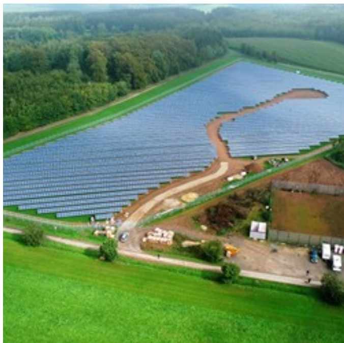
Luftbild der Photovoltaikanlage im Gewerbegebiet in Arzfeld
